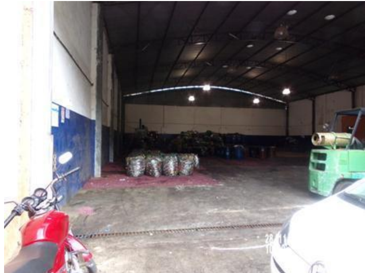
Figura 53: Galpão todo coberto Fonte: GRI-Governador Valadares, 2015
