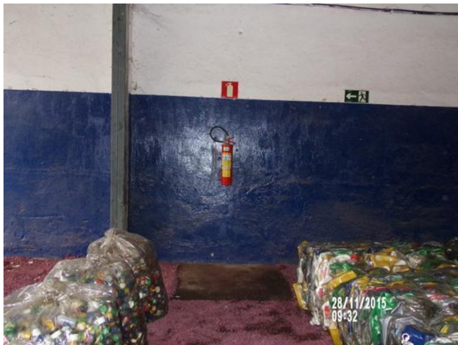
Figura 54: Solo impermealizado e extintor de incêndio Fonte: GRI-Governador Valadares, 2015
