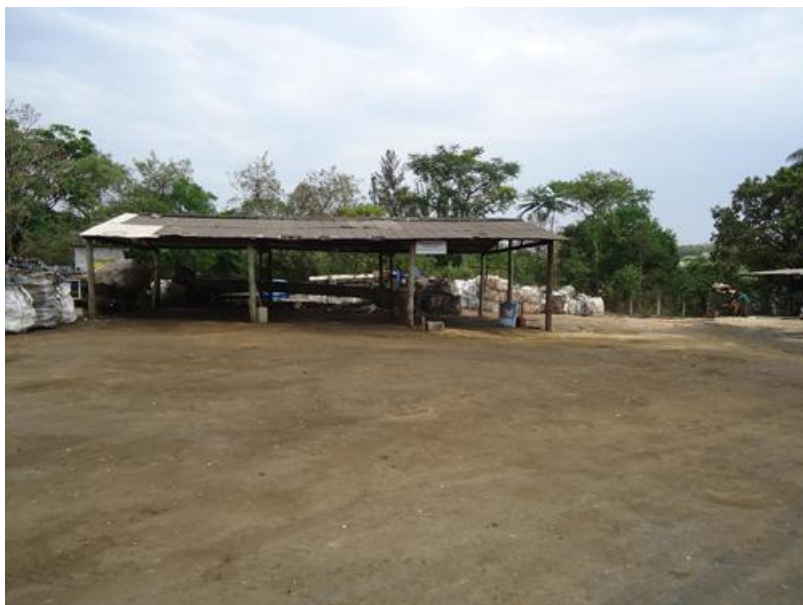
Figura 56: Única parte coberta para armazenar os resíduos Fonte: Inova, 2015
