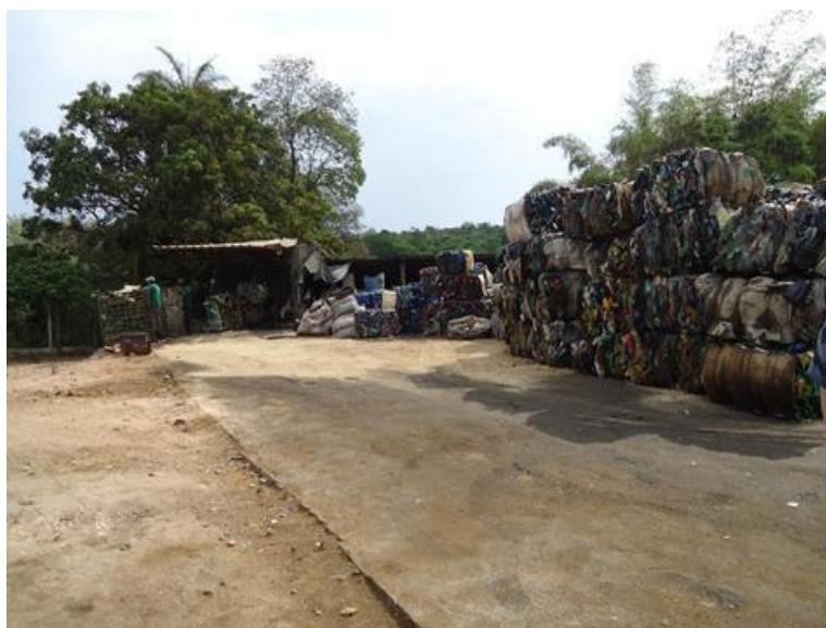
Figura 57: Piso irregular e com partes sem impermeabilização Fonte: Inova, 2015
