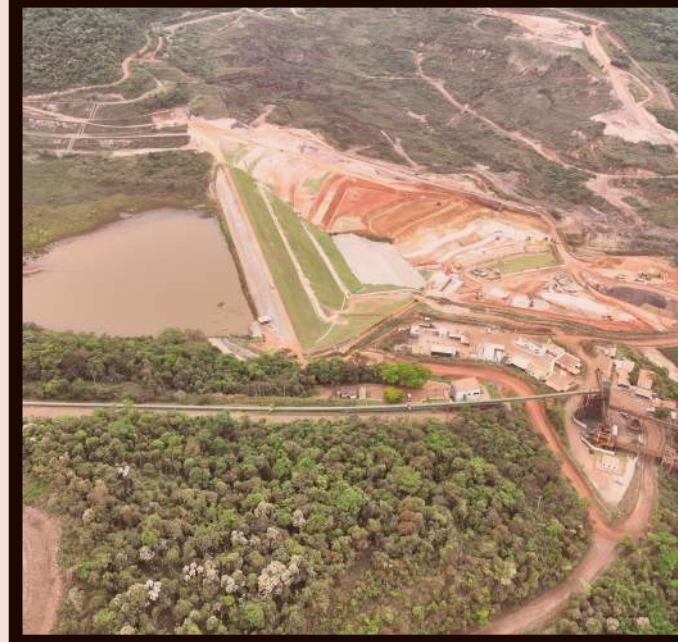
Barragem B-VI e remanescente da B-I
