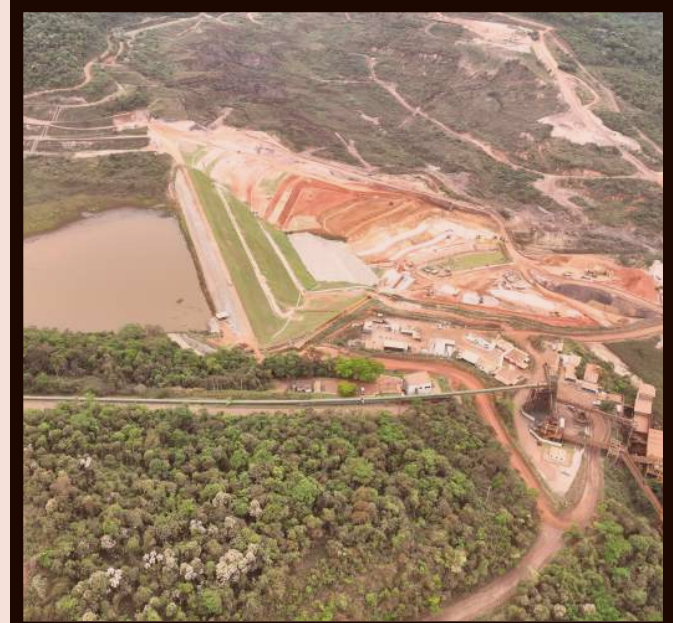
Remanescentes da Barragem B-I e Barragem B-VI
