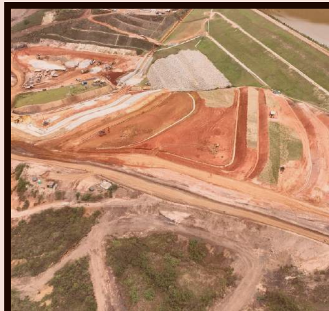
Retaludamento ombreira direita e esquerda
