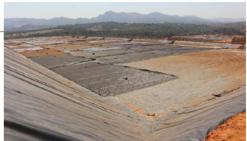
Geobags da Estação de Tratamento de Águas Fluviais dispostos em platôs (10/09/2020) Fonte: Arquivo Feam
