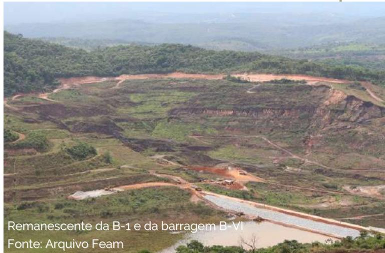
Em 2020, na estrutura remanescente da barragem B-I foram realizadas sondagens geotécnicas e obras de desvio do fluxo das águas superficiais originárias dos talwegues que estão ao redor da remanescente.
