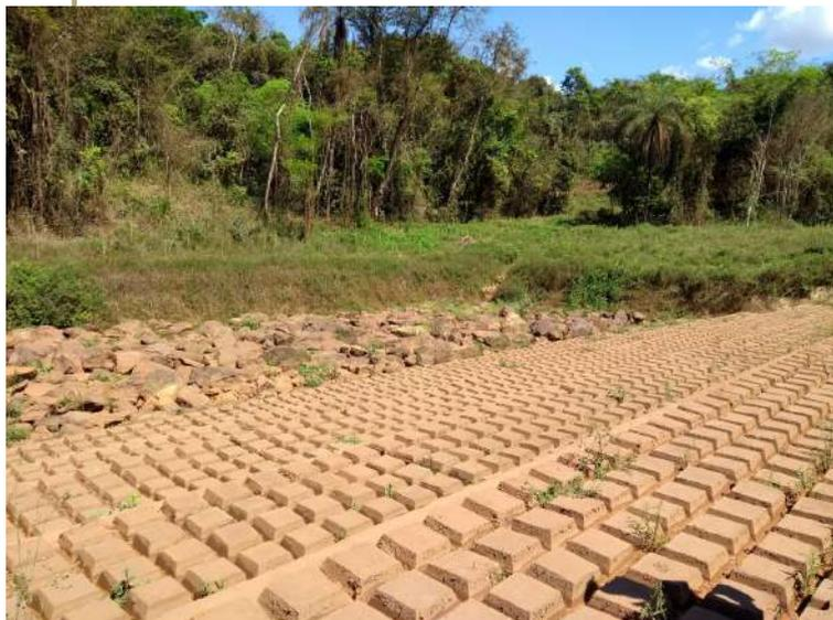
Jusante da Cortina Metálica 1 com detalhe no revestimento do canal em blocos de concreto articulados
