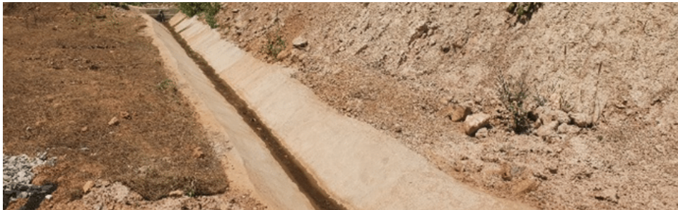
Canaleta para direcionamento do fluxo de água
