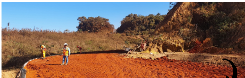
Início das obras de estabilização do talude (Mai/Jul de 2022)
