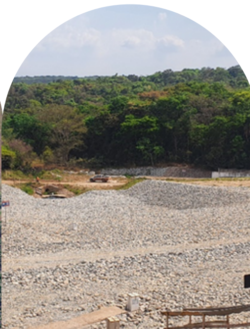
Obras concluídas à jusante da Barragem de Menezes II - 10/2022
