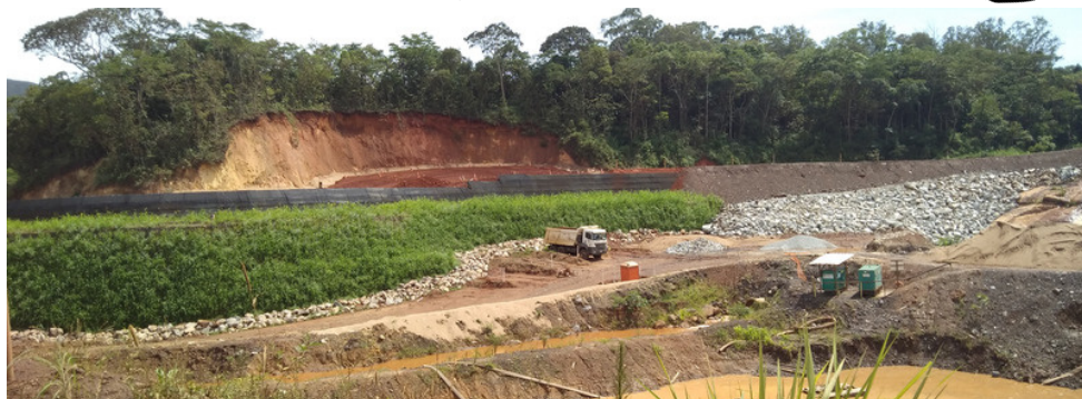
Obra de estabilização do talude (Novembro 2022)
