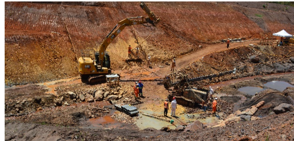
Construção das cortinas atirantadas
