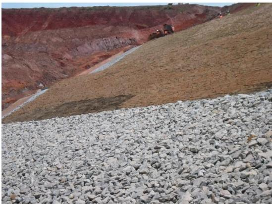
**Figura 5.4.** Processo de alteamento e plantio de grama, respectivamente, na BCP. 13/11/2013
