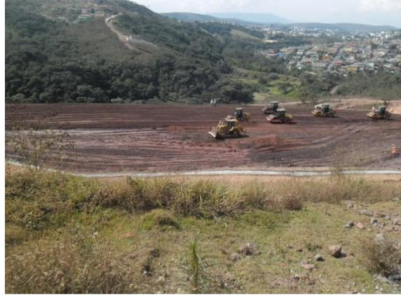
**Figura 5.3.** Barragem Casa de Pedra - BCP, em fase de alteamento. 23/07/2013
