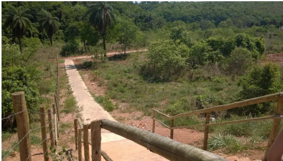
FOTO 3: Cercamento de área verde e pista que a isolará dos lotes.
