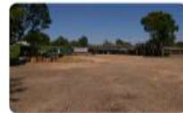
4 - Canteiro de obras (curral)
