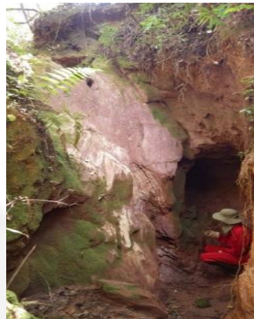
Figura 12: Drenagem intermitente escavada em xisto intemperizado. A cavidade evidenciada é uma feição erosiva criada pela energia da água. Fonte: EIA, 2014.
