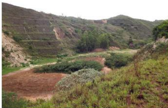
Figura 04 – Taludes revestidos com gramíneas na cava onde será implantada a vala H. Foto : EIA, 2014.
