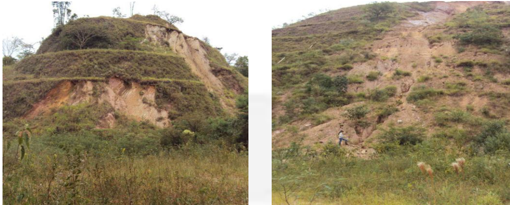
Figura 06: Feições erosivas nos taludes na cava onde será implantada a vala H. Legenda: Esquerda: Porção sul; Direita: Porção norte. Fonte: EIA, 2014.
