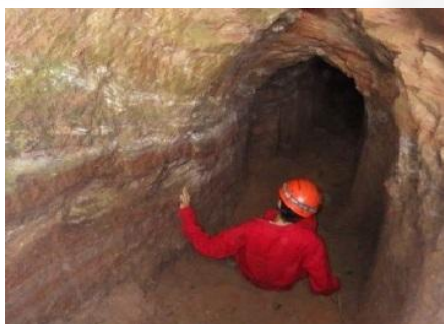
Figura 14: Detalhe da galeria seguindo mergulho da foliação. Fonte: EIA, 2014.
