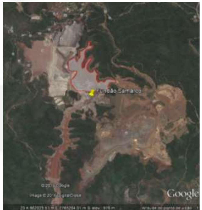
As 03 Barragens em 09/11/2015.
