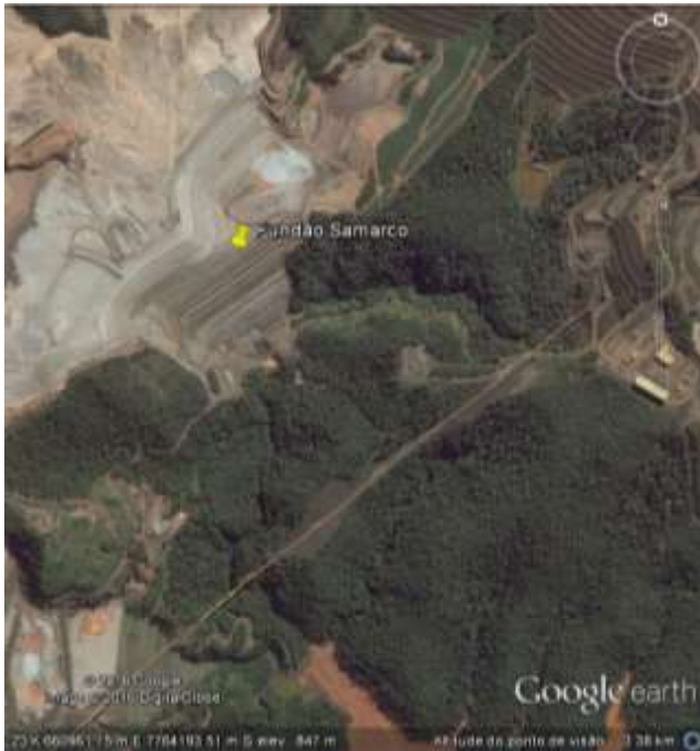
Barragem de Fundão em 20/07/2015
