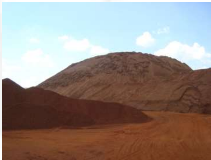
Figura 2: Vista lateral da pilha de subprodutos/rejeito implantada sem a devido projeto técnico.
