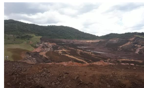
Barragem de rejeito e resíduo
