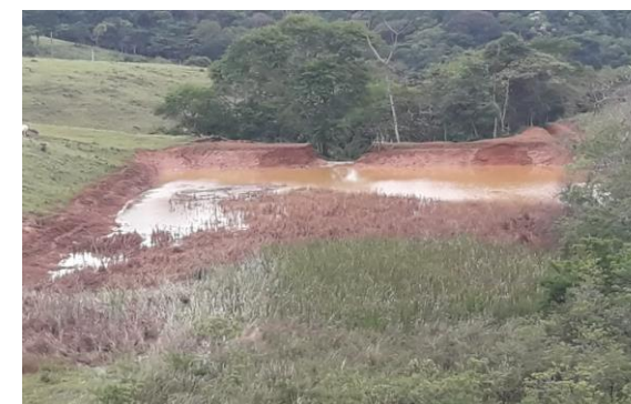
Barragem de água
