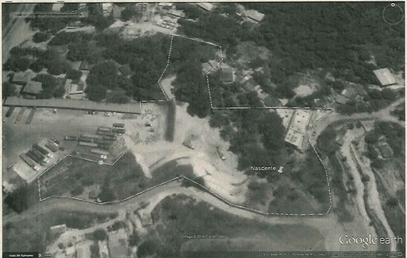
Foto 3 - Imagem de 14/10/2013 com a construção do estacionamento já avançada.
