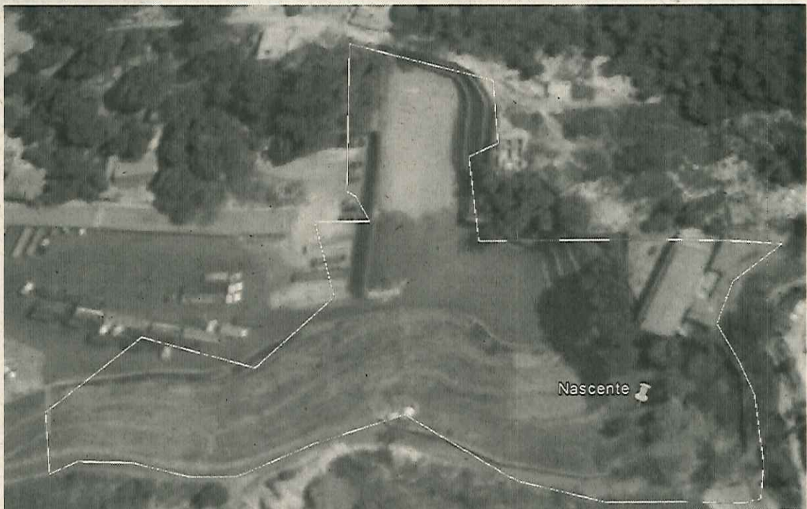
Foto 5 - Imagem da área em 19/08/2016 com o estacionamento concluído e toda a vegetação suprimida.
