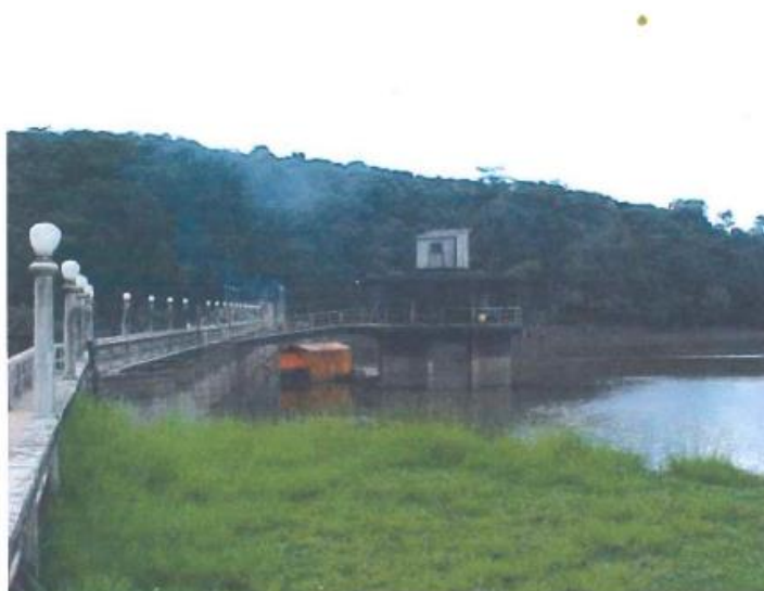
Foto 1: Vista parcial do eixo de barramento da UHE Rio de Pedras. Nota-se ao centro, mecanismo utilizado para desassoreamento do reservatório.
