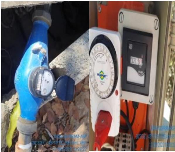
**Foto 09.** Hidrômetro e Horímetro da Captação subterrânea.
