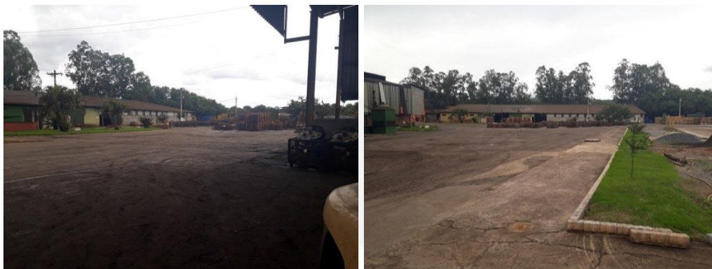
Fotos 1 e 2 – Vista geral do empreendimento.
