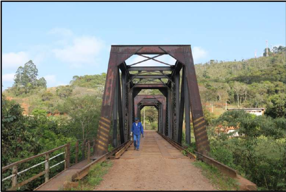
Foto 01 - Pontilhão de Ferro importado da Inglaterra, hoje usado para acesso ao bairro do Barro Branco
