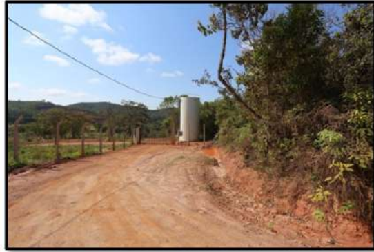
Foto 17 - Abastecimento de água do condomínio Quintas do Peti
