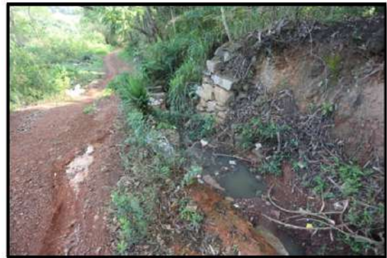
Foto 06 - Esgoto a céu aberto lançado na área de remanso do reservatório dentro do município de Santa Bárbara
