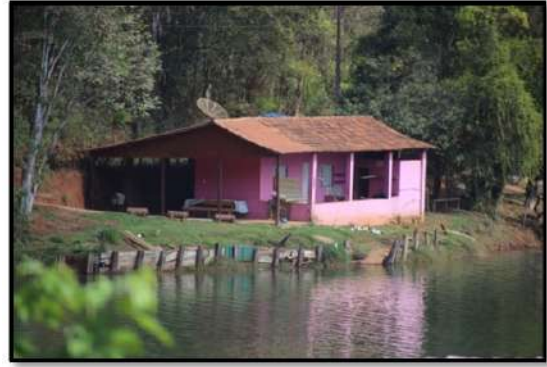
Foto 29 - Moradias na APP do reservatório na região de Lagoa do Peti
