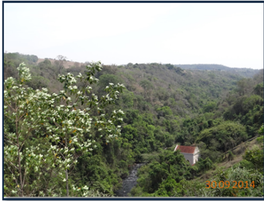
Foto 18 - Vista da mata ciliar a jusante do barramento.
