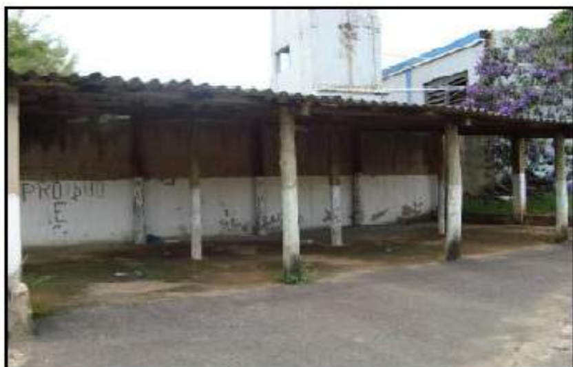
Foto N° 12– Vista do estacionamento coberto da sede da 186ª Companhia Especial.
