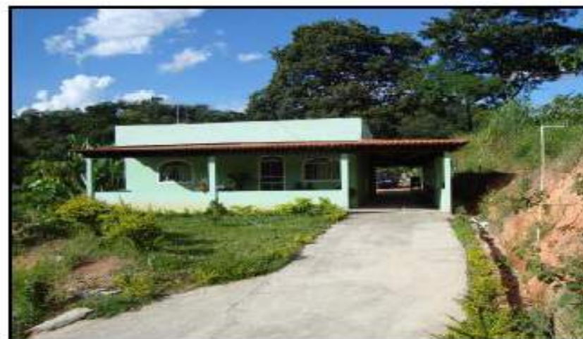
Foto N° 35– Vista frontal da casa 09.
