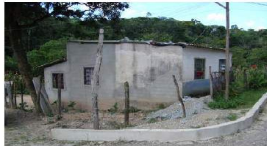
Foto N° 30– Vista geral da casa 07.
