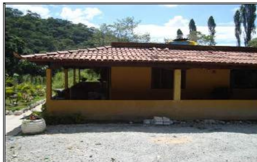
Foto N° 24 – Vista lateral da casa 05.
