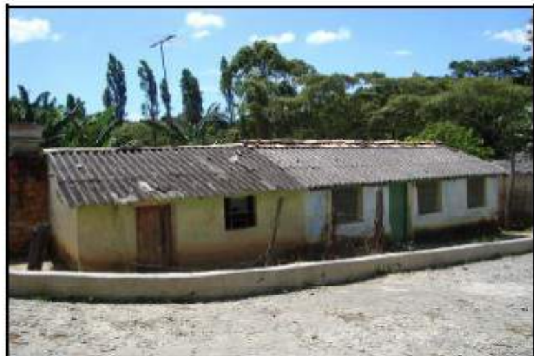
Foto Nº 19 – Vista frontal das casas 01, 02 e 03.
