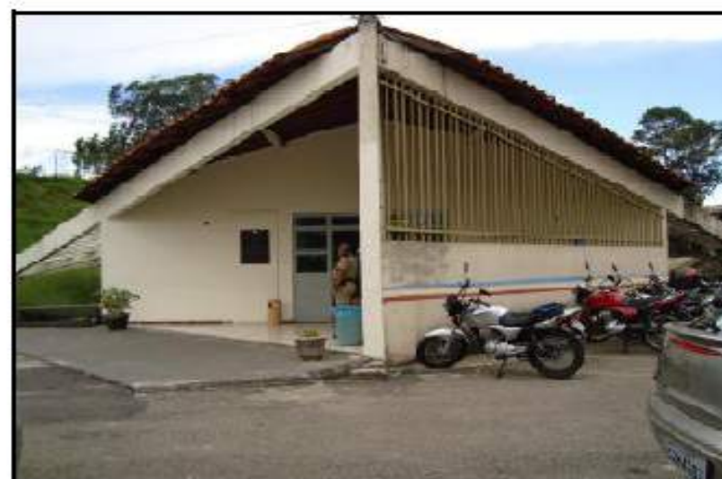
Foto Nº 10 – Vista da Sede da Polícia Militar - Contagem, situado na área interna do Parque Fernão Dias.
