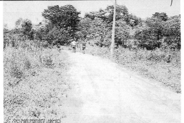
Foto 6 – Vista da rua ou acesso onde foi construída a intervenção – travessia sobre curso d'água.
