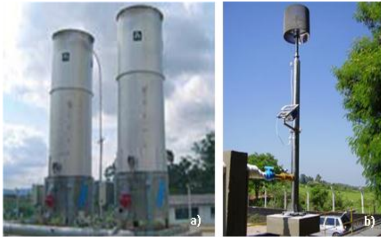
Figura 19 - Flares. a) flare enclausurado (fechado); b) flare aberto. Fonte: ICLEI (2009); Combustec (2011).
