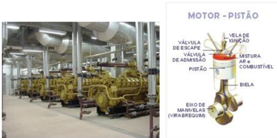
Figura 38 - Vista de motores ciclo Otto e representação esquemática do princípio de funcionamento. Fonte: Figueiredo (2007); OVERCAR (2011).
