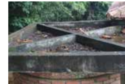
COBERTURA Limpeza da laje externa.
