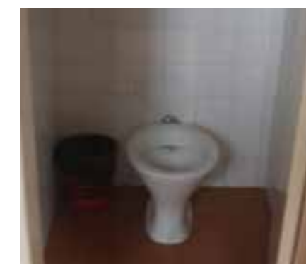
HIDRÁULICA Trocar as bacias, pois estão danificadas. Um ponto de descarga precisa ser repostado.
