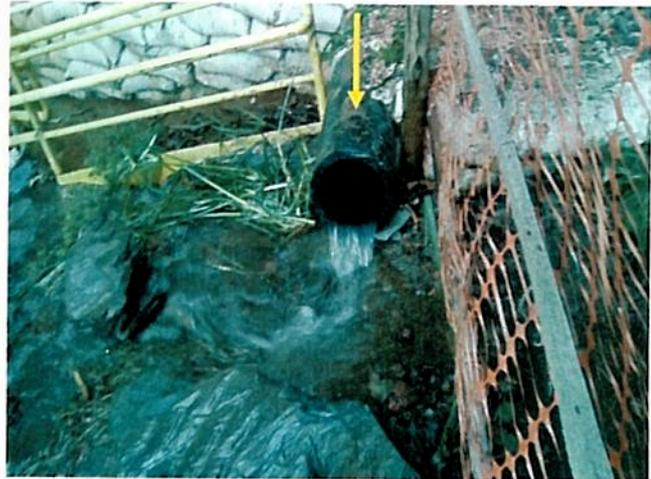
Foto 2: Local de corte da tubulação de desvio e ponto de lançamento atual que segue a drenagem natural conforme indicação da Foto 3.
