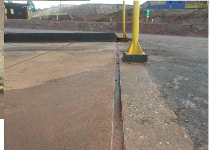
Bacia de contenção construída de forma equivocada
