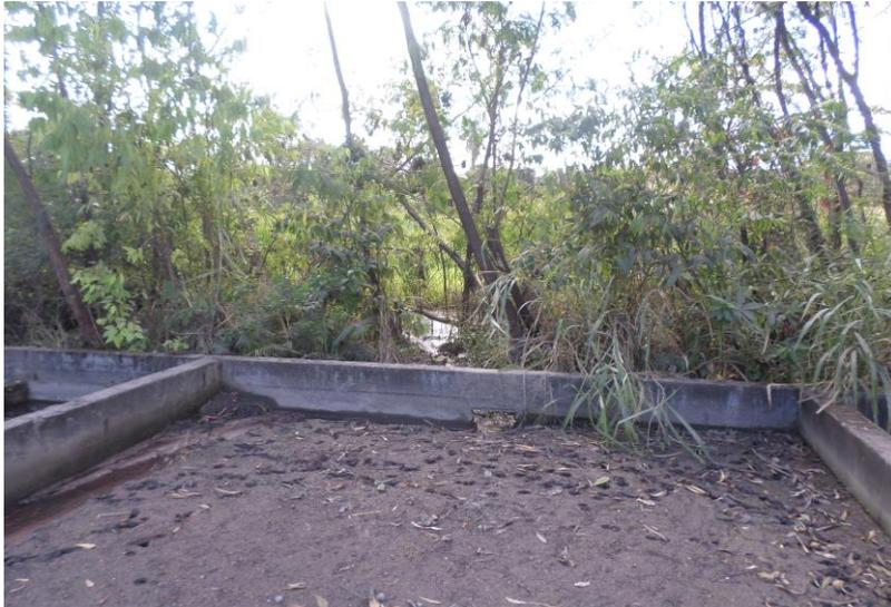
Falta de sistema de drenagem ocasionando carreamento de sedimentos
